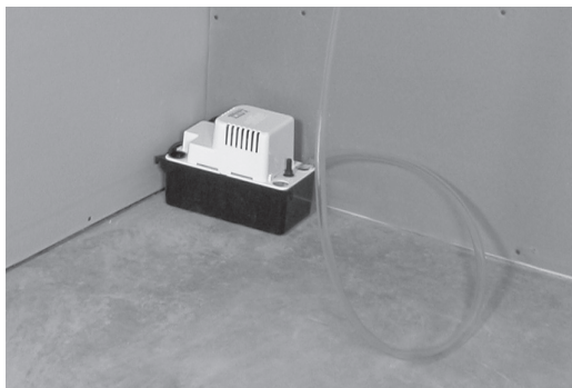
Ensuite, raccorder au renvoi ou à la pompe de condensation si vous n'avez pas accès au drain du plancher.
