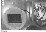
4 Retirer la vis (C) de retenue du condensateur sur le côté du compartiment électrique. Remplacer le condensateur défectueux par un nouveau.
